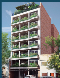
DM 54 - PH Constructora
