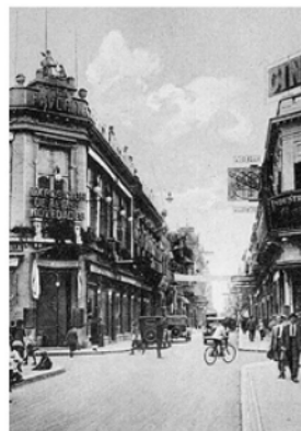
Calle Córdoba en su cruce con Sarmiento en 1923
