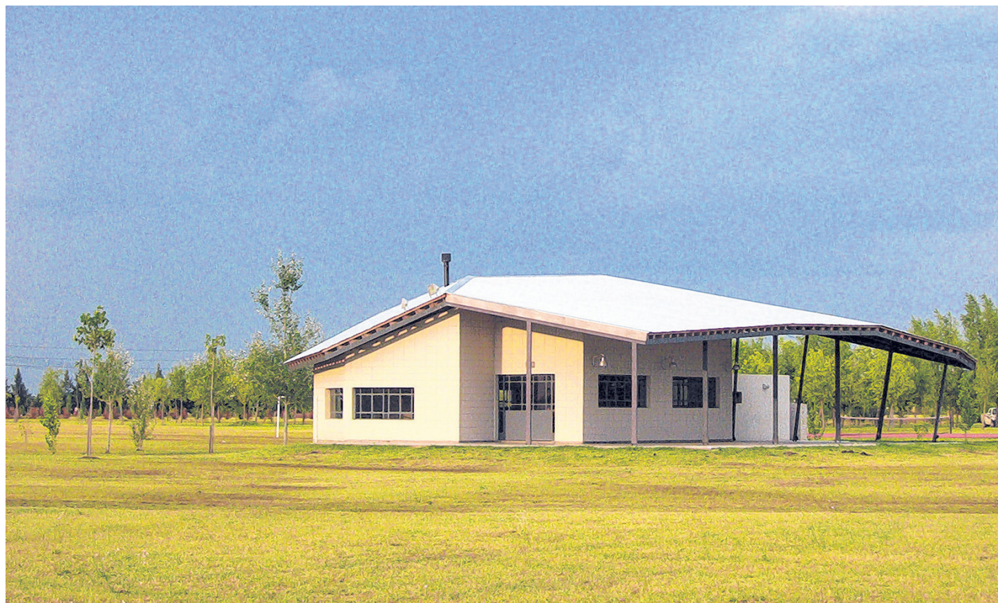
Club House Los Raigales, Roldán, 2005/06 - Arq. Marcelo Villafañe. Fotografía: Carlos Candia.
